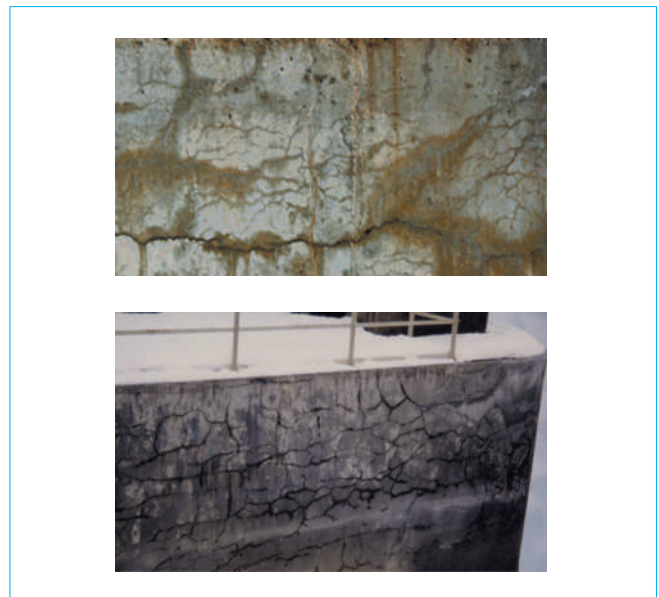
Figure 4 – Exemples de dégradations d'ouvrages dues à l'alcali-réaction
